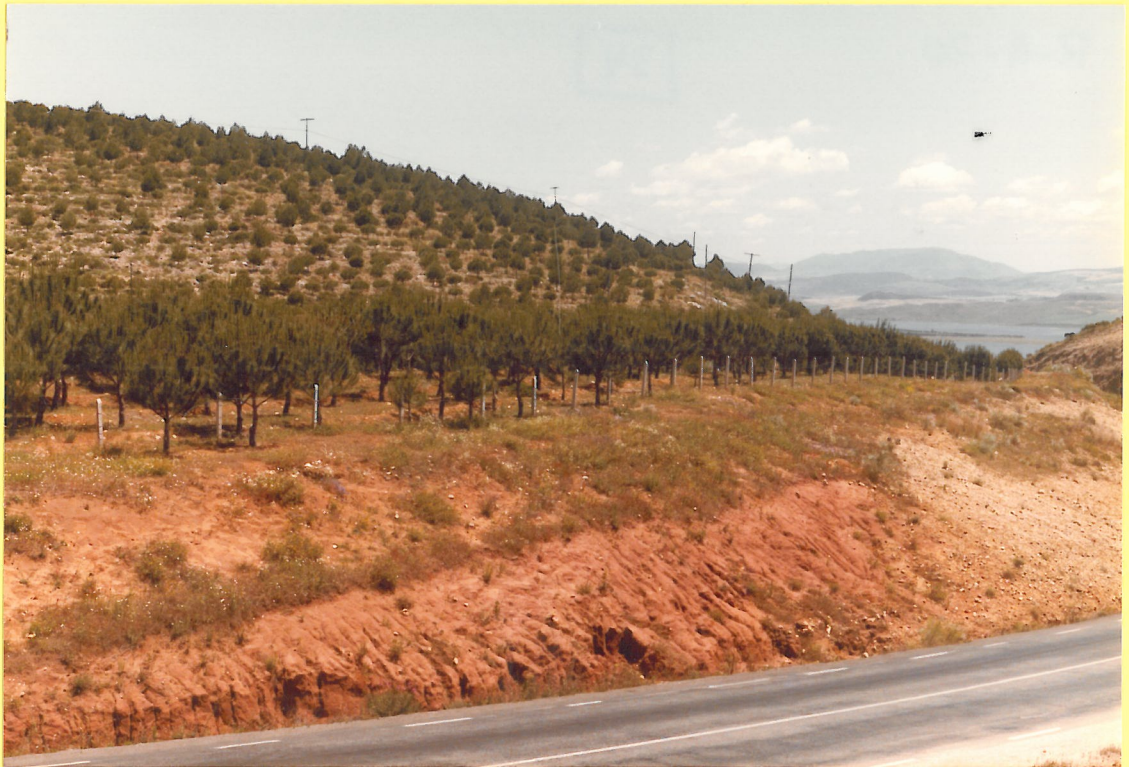
34. Misma localidad que la anterior. Términos arenosos rojizos producidos por la alteración con decalcificación de las calcarenitas subyacentes a la derecha de la fotografía.
